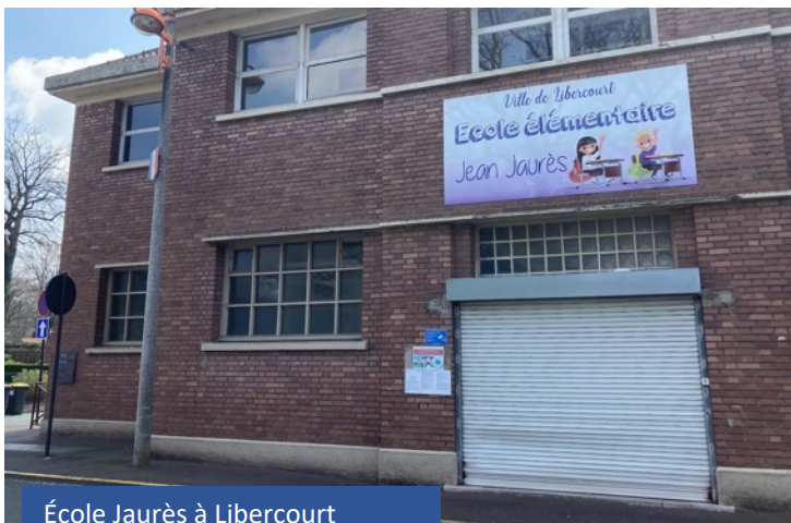
École Jaurès à Libercourt
