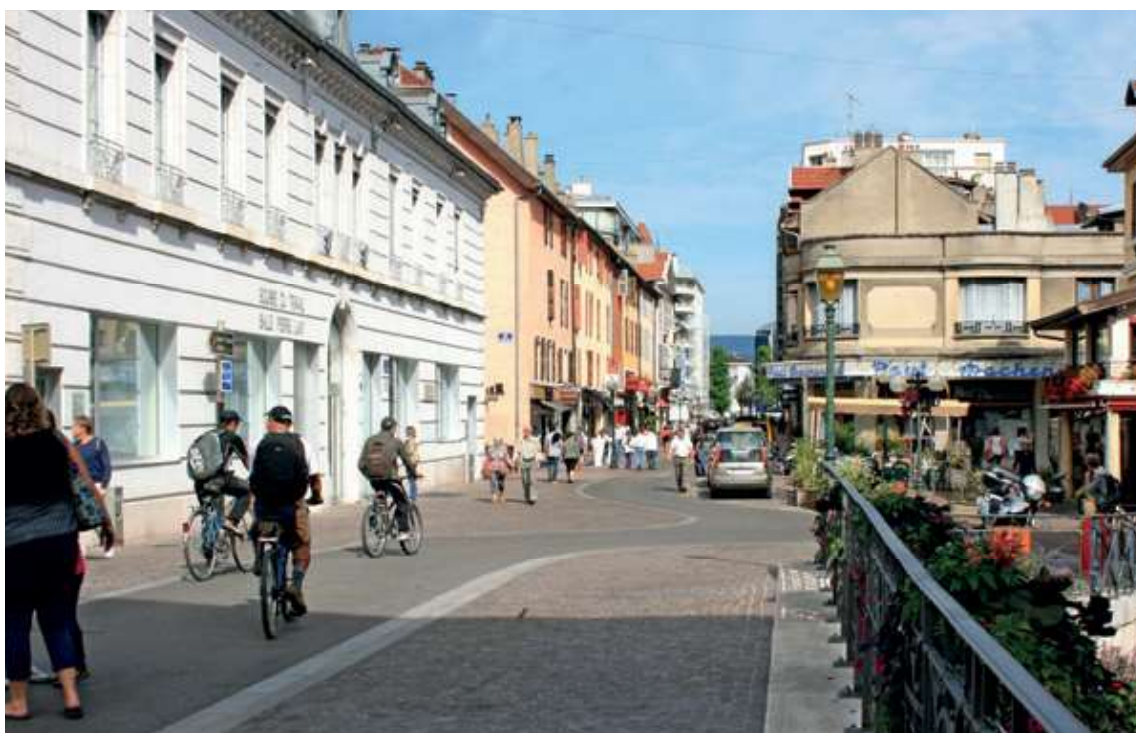
Intersection en face d'une salle de spectacle. Une chaussée sinueuse remplace l'ancien tracé rectiligne, afin de dégager un parvis devant l'entrée de la salle de spectacle.
