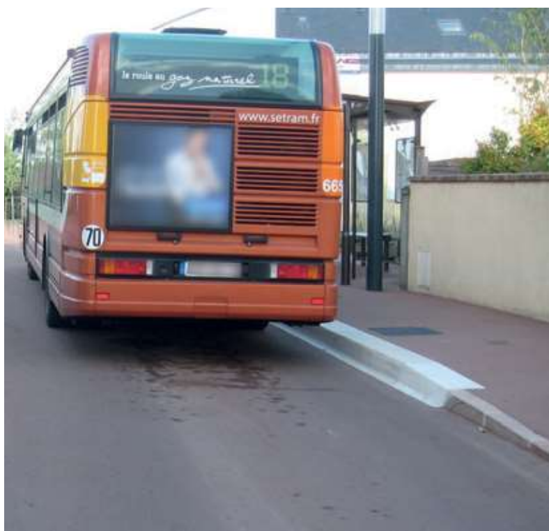
Dans cette zone de rencontre, une partie de l'aménagement est surélevée pour créer un quai, respectant les règles d'accessibilité, au niveau de l'arrêt de bus.
