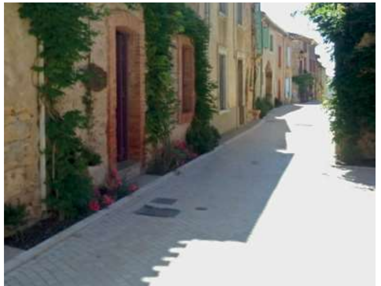
Ici, l'espace de frontage est matérialisé par une bordure basse. Elle permet de gérer les débords de seuil et d'améliorer le cadre de la rue, grâce à la végétation. Les piétons qui ont besoin d'un guide pour se déplacer, une sorte de fil d'Ariane, peuvent suivre cette bordure qui est continue sur la longueur de la rue et permet d'éviter les zigzags et débords.
