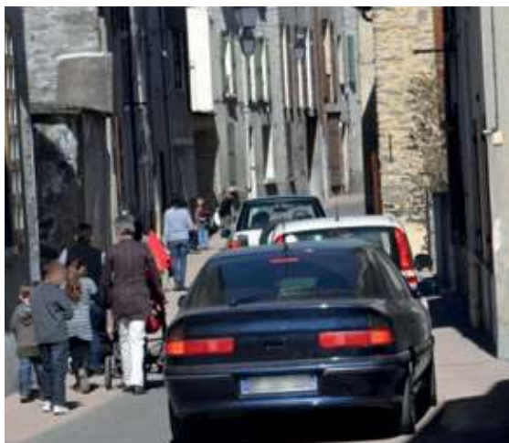
Rue étroite en centre ancien. L'aménagement est à niveau avec un jeu de couleurs. Une bande centrale en noir, de 2 m de large, guide les véhicules et les bords en rose s'adaptent à la largeur de la rue. Visuellement, l'espace des véhicules est le plus petit possible et c'est l'espace en lien avec les riverains qui évolue et s'élargit avec l'espace disponible.
