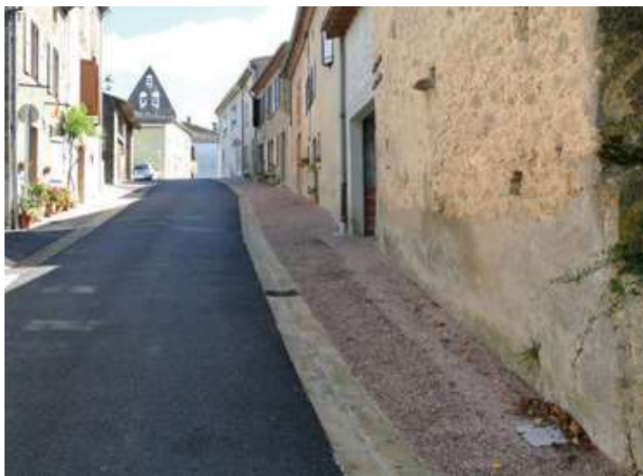
Emprise de la chaussée réduite et création d'un cheminement piéton
