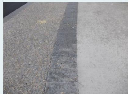
Dispositif séparatif entre piste cyclable et trottoir à Nantes Métropole
